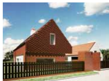
Widok od strony ulicy
