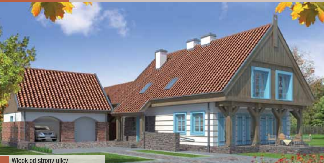
Widok od strony ulicy
