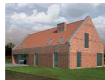
Widok od strony ulicy
