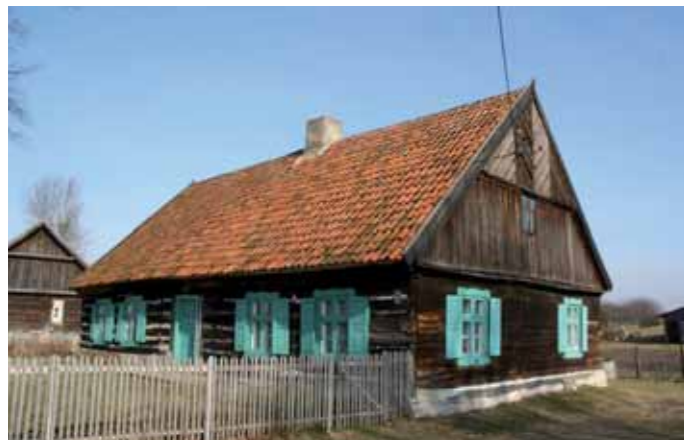
Marcinkowo, tradycyjna chałupa drewniana o konstrukcji zrębowej
